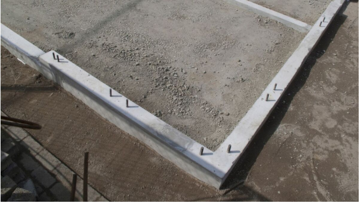
Fundament aus Beton
