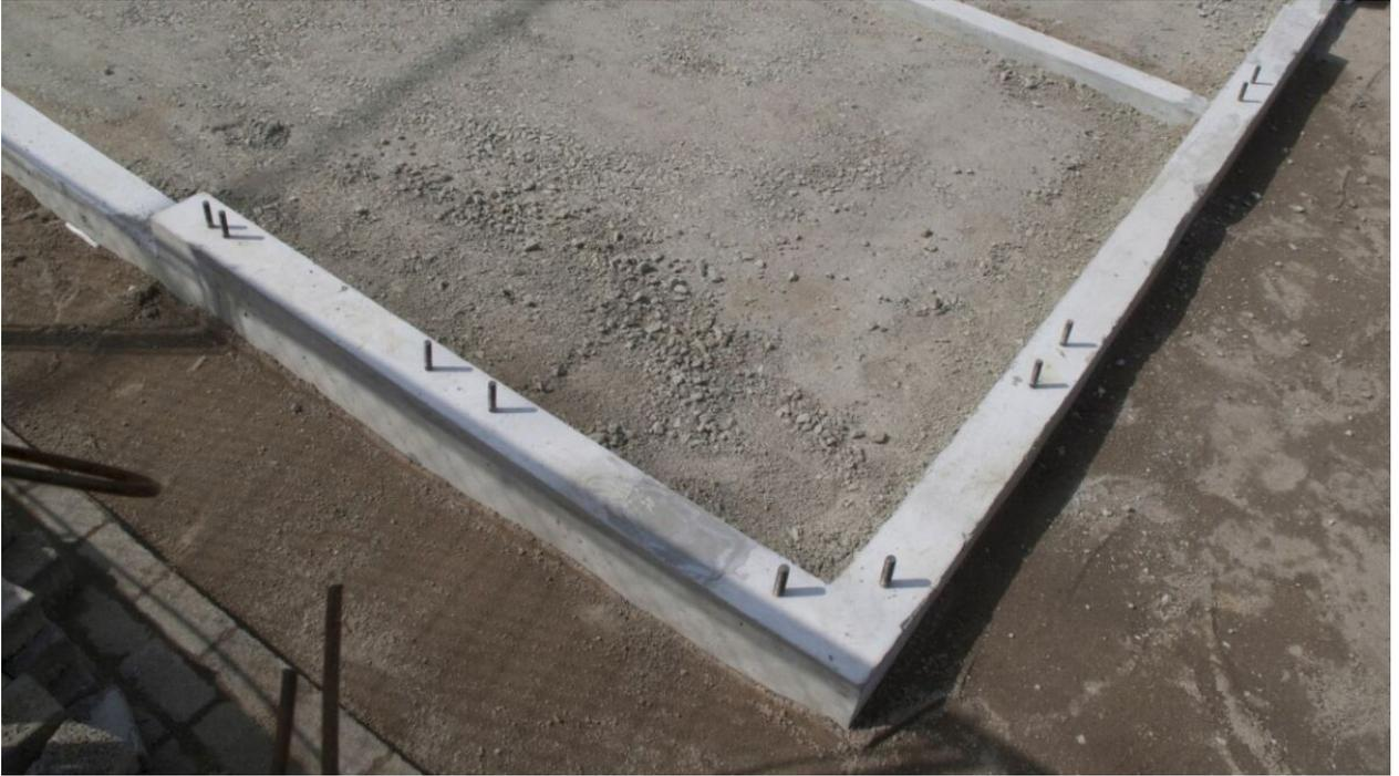
Fundament aus Beton
